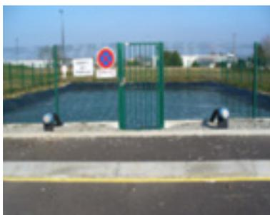
L'aspiration s'effectue par un dispositif de raccordement aux engins incendie, installé à demeure et raccordé à la réserve incendie (voir [fiche technique 9](#)).
