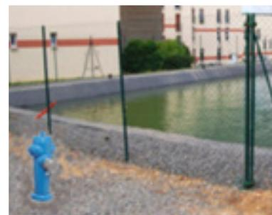
L'aspiration s'effectue sur un ou des poteau(x) d'aspiration, raccordé(s) à la réserve ouverte par une tuyauterie enterrée (voir [fiche technique 10](#)).
