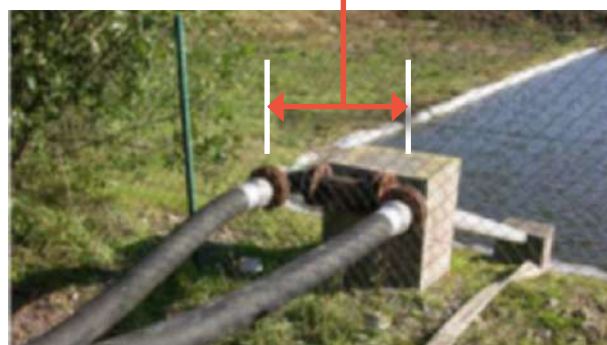
Sur une colonne de 150 mm, l'écartement entre les deux sorties de 100 mm doit être compris entre 0,4 et 0,8 m.
