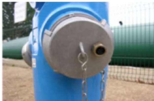
Exemple de dispositif de vidange sur bouchon obturateur
